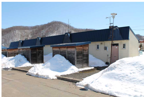
築後36年経過した寡婦住宅
