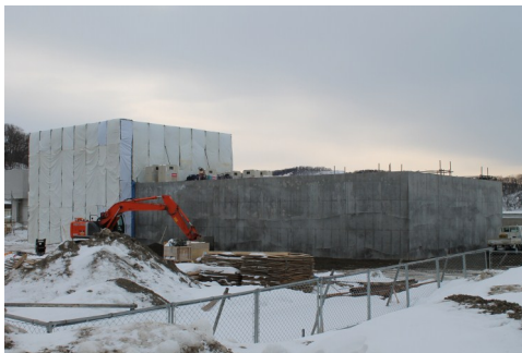
建設中の佐呂間漁協排水処理施設
