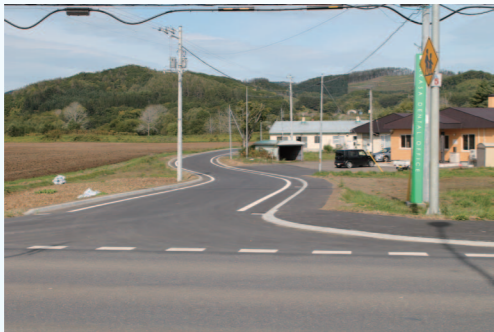
全線完成した若佐保育所前道路
