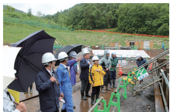
ごみ焼却施設の建設状況を確認する
