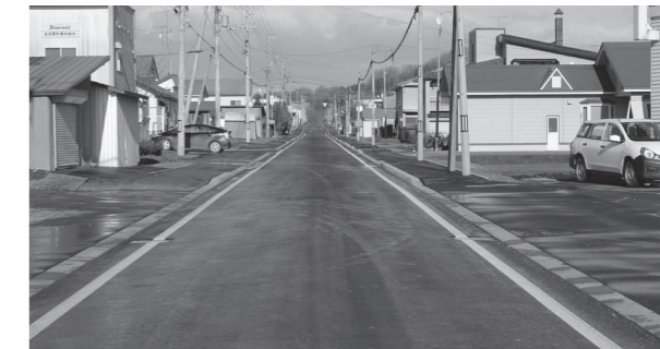
改良により通行しやすくなった佐呂間30号道路
