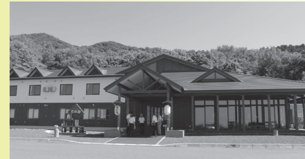
コロナ禍に対応した営業を行うため改修する悠林館
