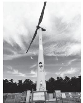
ローターまでの高さ85m、回転口径最大幅77m、ブレード1個の長さ37m、年間売電電力量2万3900メガワットあり、これは住民6600世帯分の電力を賄う能力であり、二酸化炭素削減量は1万3300トンに及び、事業費は約28億円、財源は補助金7億円（国立研究開発法人新エネルギー・産業技術総合開発機構）、公営企業債20・5億円となっており、電力の売電は中国電力へ変換した高圧電力を送電しているが、鳥取県中部で地域新電力「鳥取みらい電力」の令和5年4月からの稼働に伴い、「域内経済循環」を目指し、売電を切り替えている。
