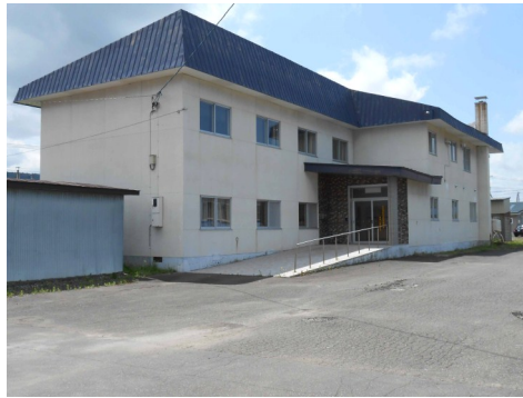
クリニック新築のため解体される「しらぎく」
