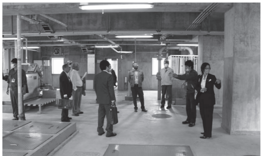
佐呂間別川へ放流される前の最終沈殿池
