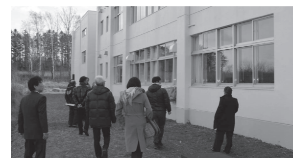
外壁改修とサッシ防水工事が行われた浜佐呂間小学校
