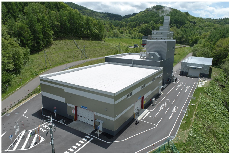
写真 3-5-1 えんがるリサイクルセンター
