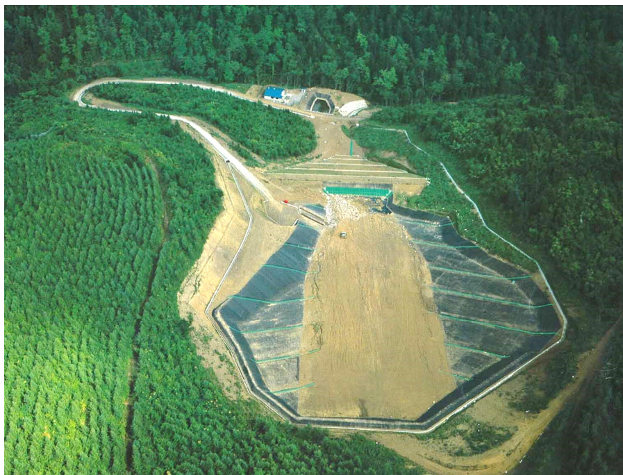
写真 3-5-3 佐呂間町一般廃棄物最終処分場（竣工時）
